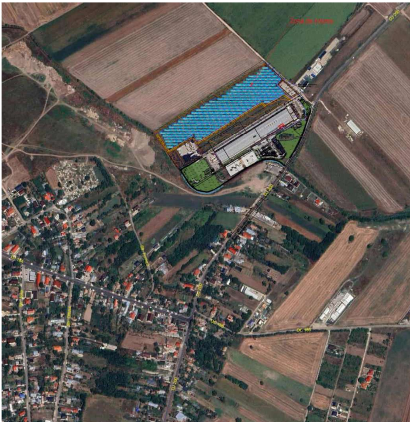
Figură 7 - Vedere de sus a locației propuse pentru centrala Electrică cu Panouri Fotovoltaice
