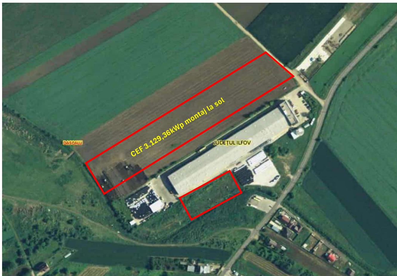
Figură 1 - Vedere de ansamblu: CEF 3.542,50 kWp RESILUX PACKAGING SOUTH EAST EUROPE S.R.L.
